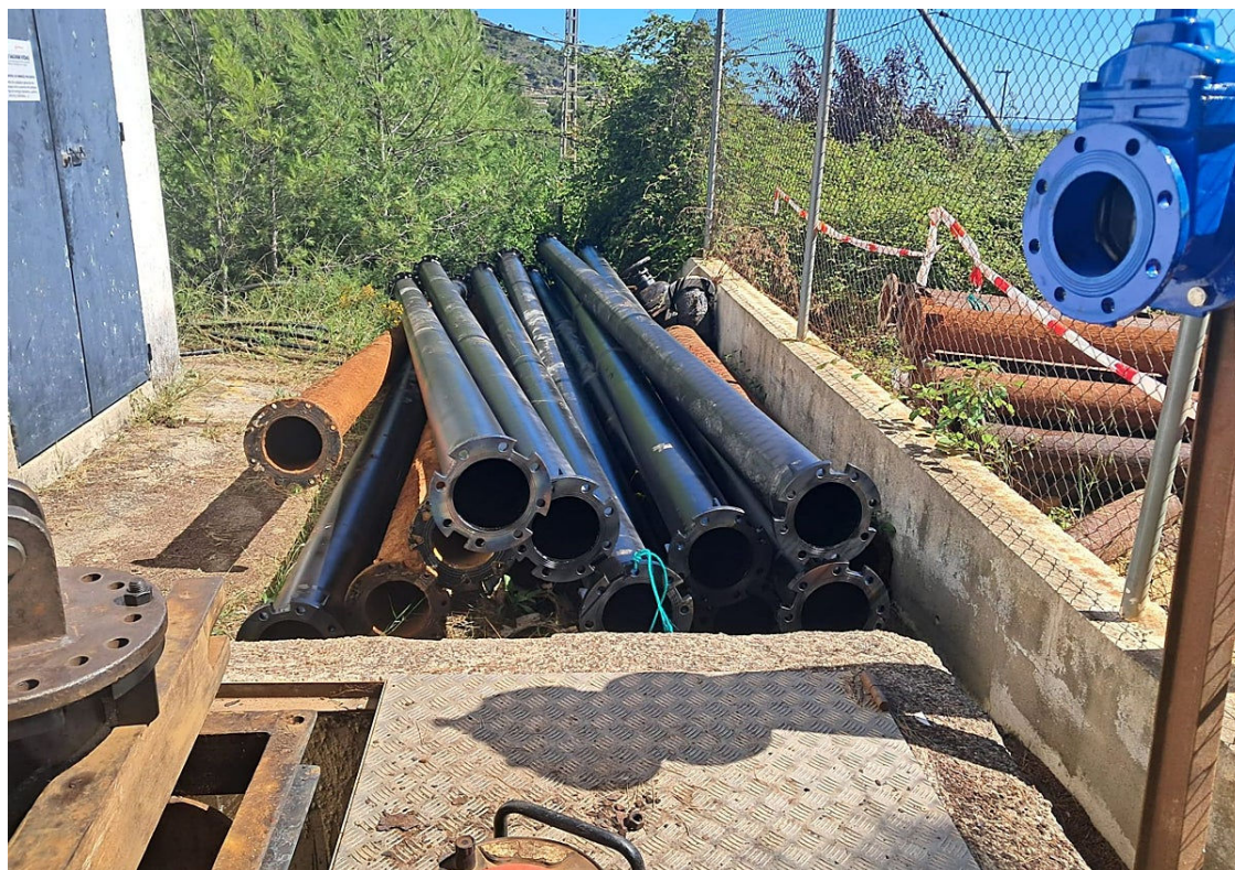
Obras en Xeraco (Valencia). (ABC)
